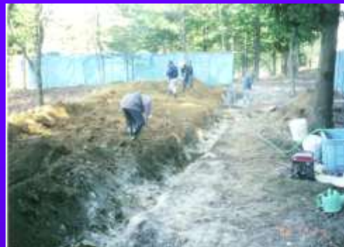
(ミキシング)埋め戻し処理
