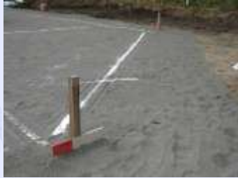
① 透水性のよい母材土壌を均一に敷き均す
