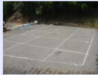
③ 母剤施工完了
