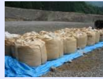
④ 資材搬入完了
