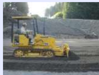
⑪ ブルドーザーによる不陸修正
