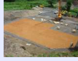
⑧ 資材敷き均し完成
