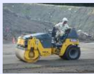
⑫ ロードローラーによる転圧
